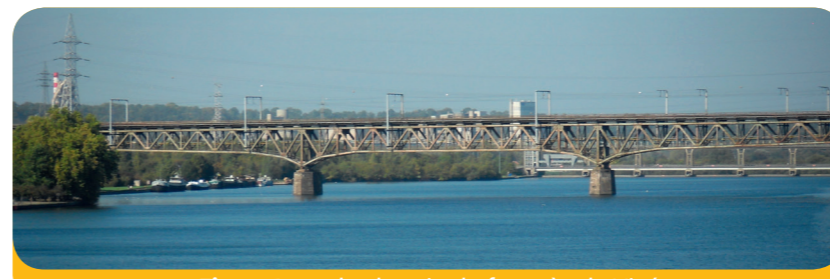
Fig. 5: Pont de chemin de fer près de Visé
