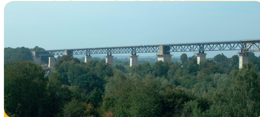
Fig. 4: Un des ponts de chemin de fer les plus longs d'Europe : il a plus de 100 ans et mesure plus d'1 km de long. Le viaduc de Moresnet.
